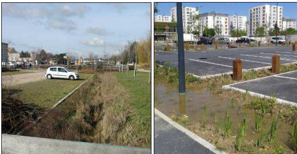
Exemples de noues d'infiltration à Marcoussis et dans le quartier des Joncs à Fleury-Mérogis
