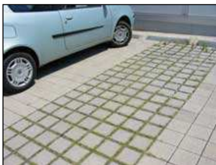
Exemple de pavés poreux (Source : Grand Lyon, Fiche n°1 Revêtements de surface poreux, d'après FEBESTRAL)
